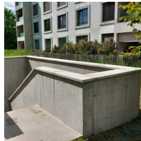
| Mauerkronenabdeckung auf Brüstung
