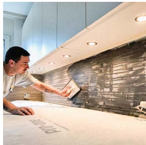
| Plattenarbeiten bei einem Küchenumbau
