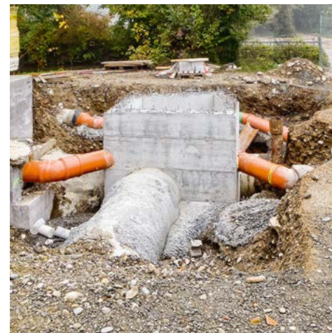
| Betonarbeiten bei einem Spezialschacht
