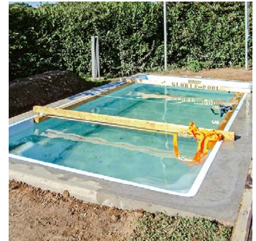
| Ausheben und versetzen eines Gartenpools
