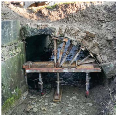
| Sanierung Bachdurchlass
