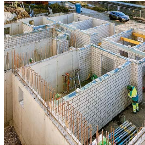
| Neubau Mehrfamilienhaus mit Mauerwerk im Keller
