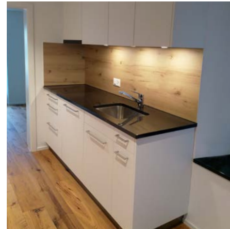
| Innenausbau Altbauwohnung, Aarau
