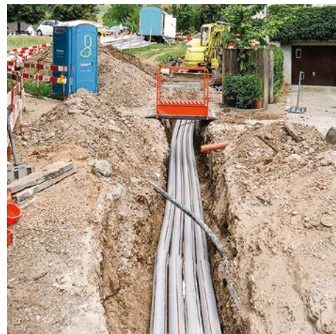
| Grabenaushub und Verlegen von Werkleitungen
